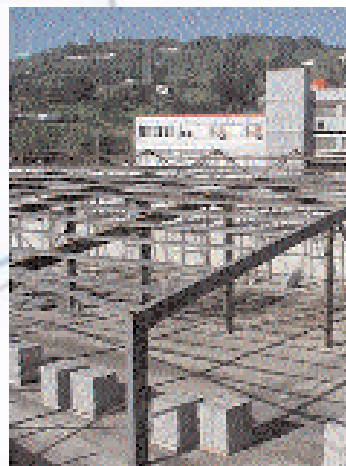
Estado actual del pabellón industrial
