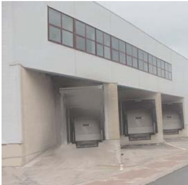
Muelles de carga y descarga del nuevo taller
