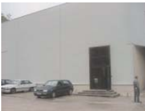
Aparcamiento y puerta de acceso
